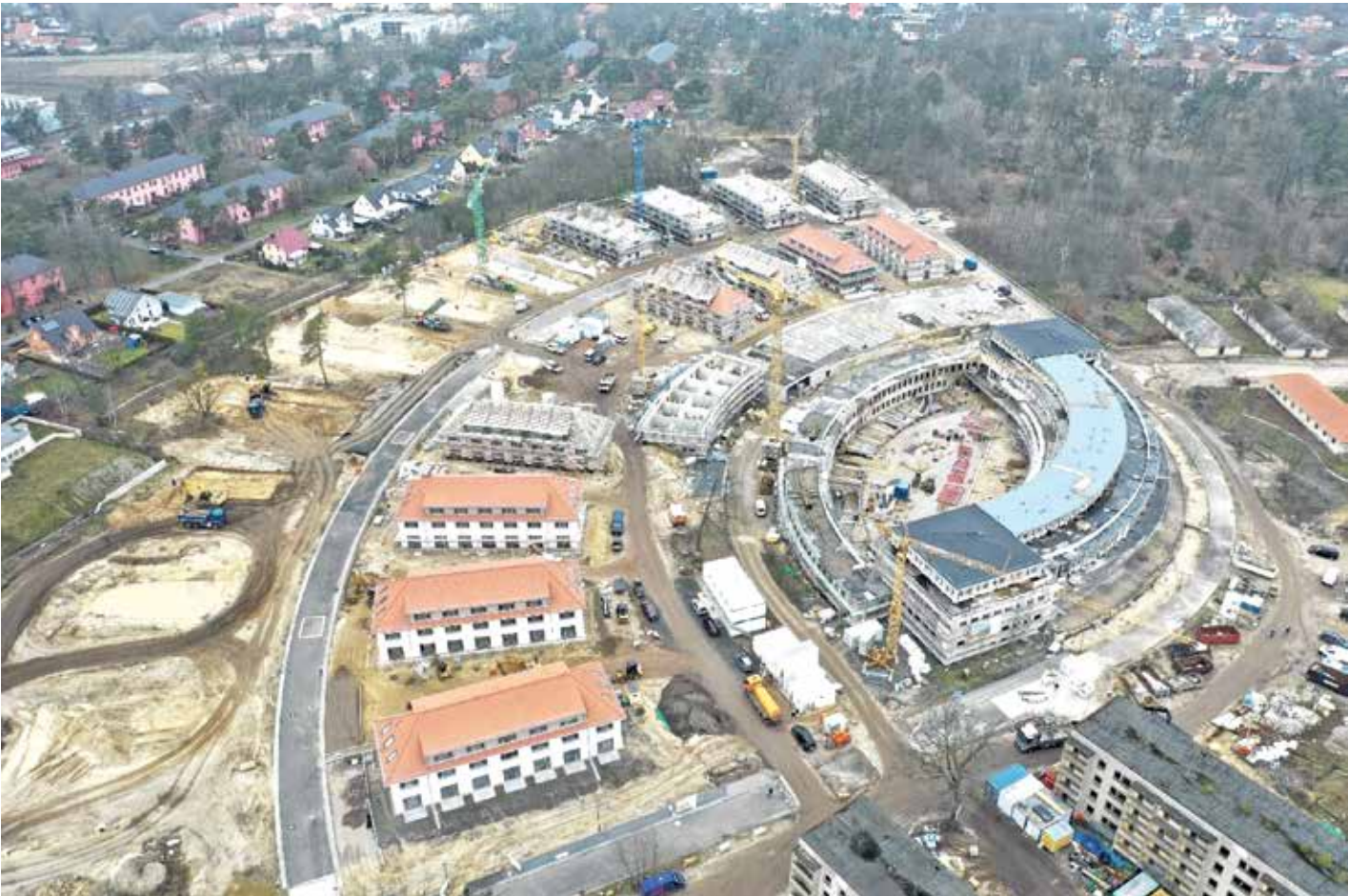
Im Olympischen Dorf wird fleißig gebaut: I. Bauabschnitt der terraplan mit Speisehaus der Nationen, Haus Central, Tiefgaragen, Innerem und Grünem Ring. (Aufnahme: Marco Voigt, Berlin, Stand: Feb. 2020)
