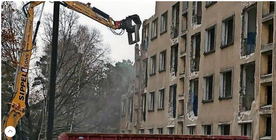
Zwei der alten Plattenbauten im Olympischen Dorf müssen weichen. Die anderen werden saniert. Quelle: Sebastian Morgner
