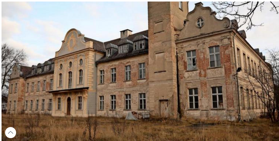
Einer der vorherigen Nutzer hat den Mittelteil (Rückansicht) saniert. Quelle: Uwe Halling
