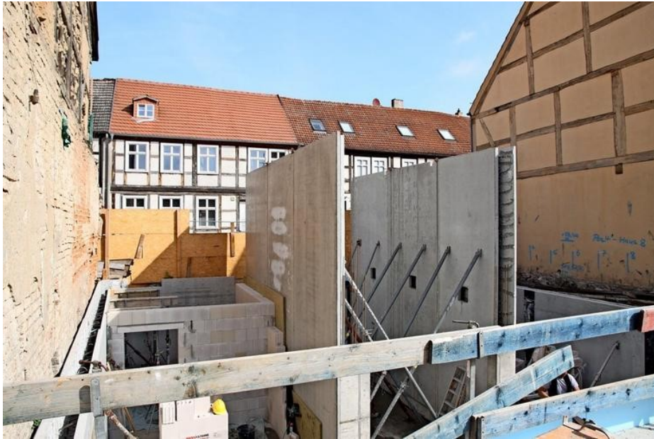
Der Eingang zur Tiefgarage. Da werden die Autos Fahrstuhl fahren. Quelle: Andreas Kaatz
