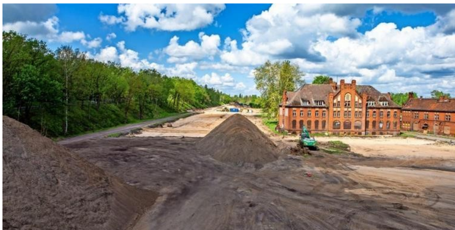
Viele Tonne Erde werden auf dem Bahn-Technologie-Campus in Elstal bewegt. Quelle: Enrico Berg
