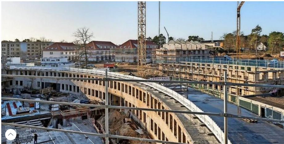
Am ehemaligen Speisehaus der Nationen im Olympischen Dorf wird kräftig gebaut. Quelle: privat
