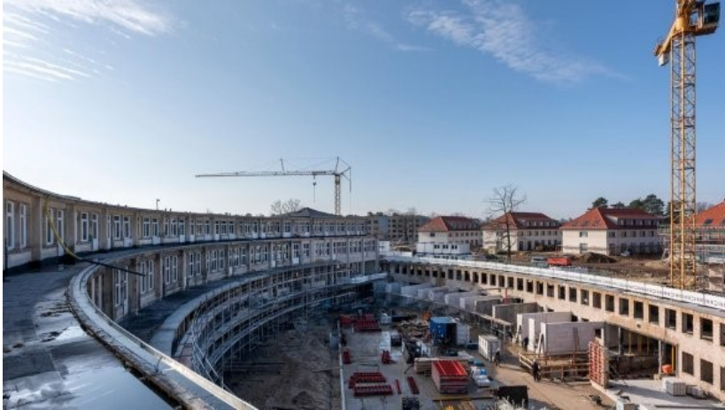
Das ellipsenförmige "Speisehaus der Nationen" ist momentan eine Großbaustelle.
