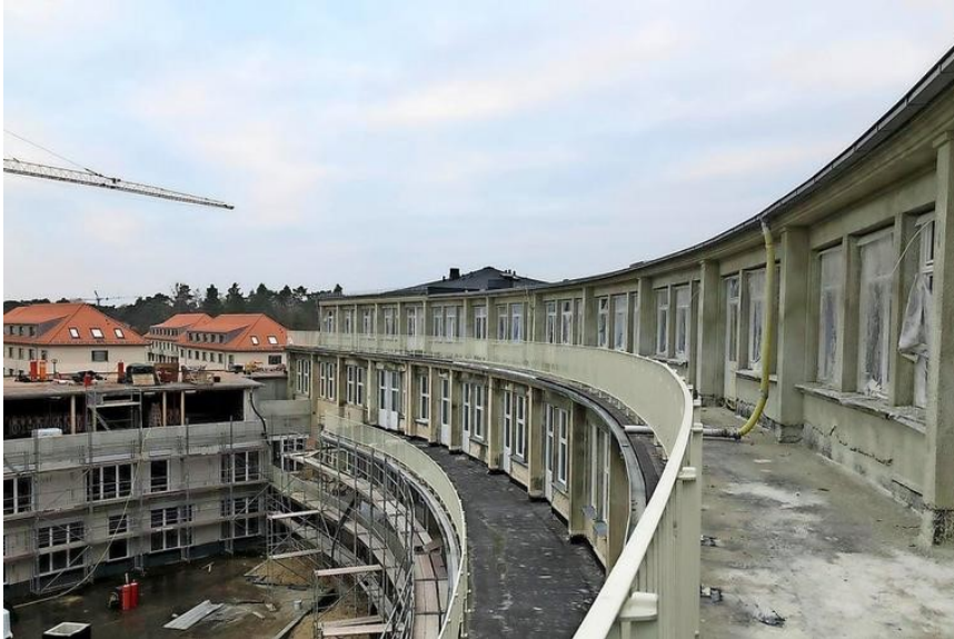
Die originalen Geländer wurden wieder verwendet. Quelle: Sebastian Morgner
