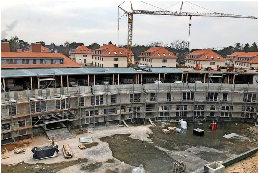
Der Umbau des Speisehauses geht voran. Quelle: Sebastian Morgner
